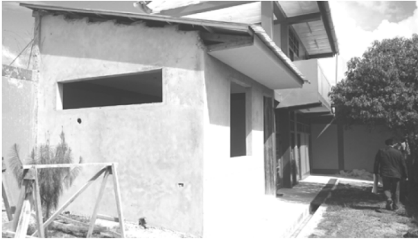
Das Küchengebäude ist fast fertig gestellt – noch fehlen die Fenster
