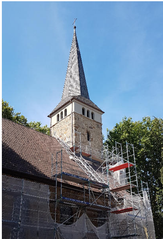
Sanierung Pauluskirche (Aug. 2018): Das Gerüst um den Turm ist schon abgebaut (Foto: Welge).
